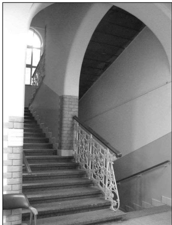
2.3.6. kép.: gyámolított lépcső a Műszaki Könyvtárban
