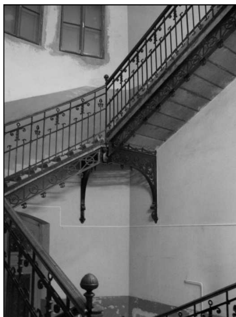
2.3.8. kép: kovácsoltvas tartószerkezet
