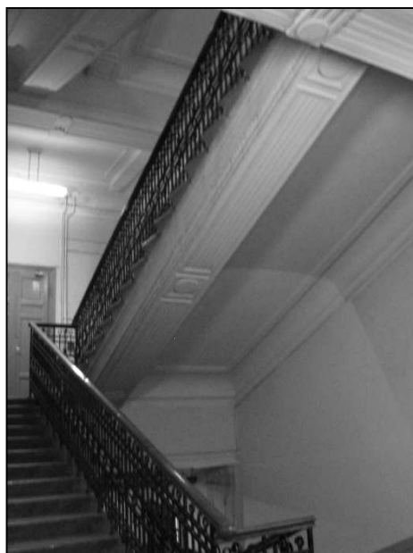
2.3.9. kép: Acél gerendás gyámolítás
